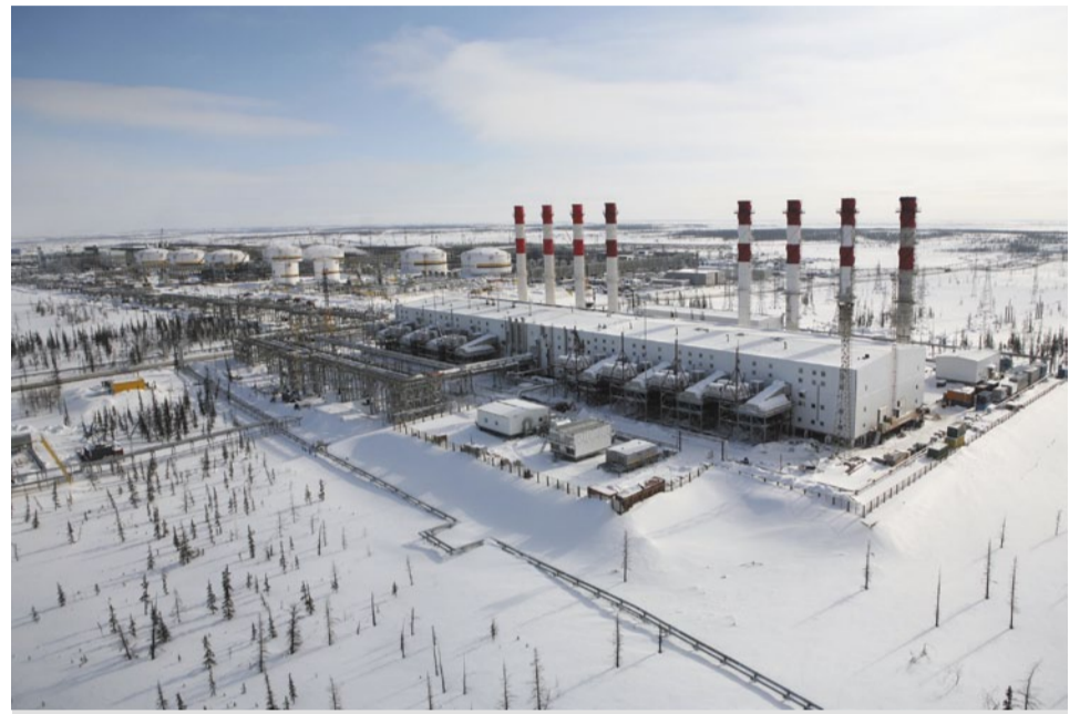
Строительство на месторождении пришлось вести в сложнейших природных условиях
